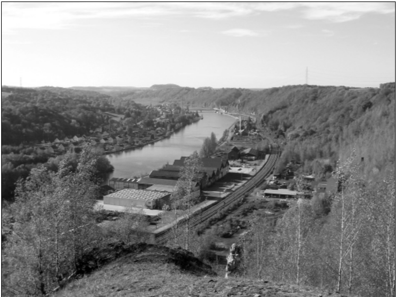
Photo 1. – Vestiges du passé industriel du site de Sclaigieux (photo D. Ghyselinck).
